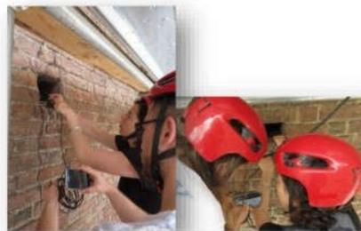
Ispezione delle buche pontaiate tramite endoscopio.
