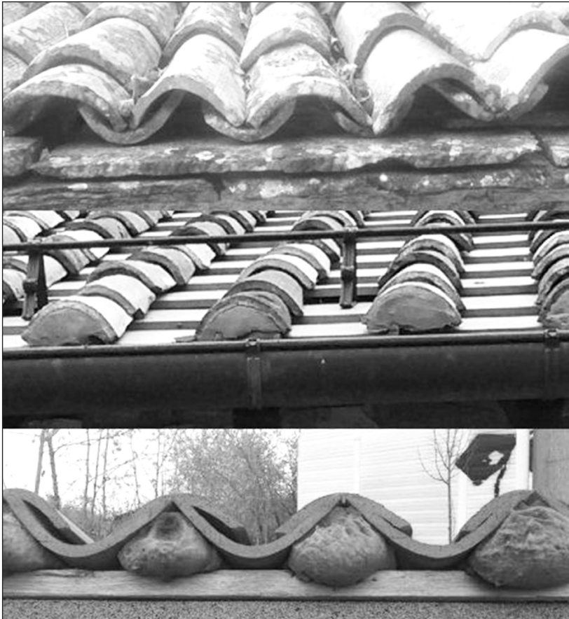
Fig. 31 – I coppi non sigillati (sopra: Appennino modenese) sono una grande risorsa per i rondoni comune e pallido; sigillarli con malta (al centro: Appennino romagnolo) o con poliuretano (in basso: Appennino modenese), causa mortalità ed esclude per sempre le piccole specie animali (foto M. Ferri).
