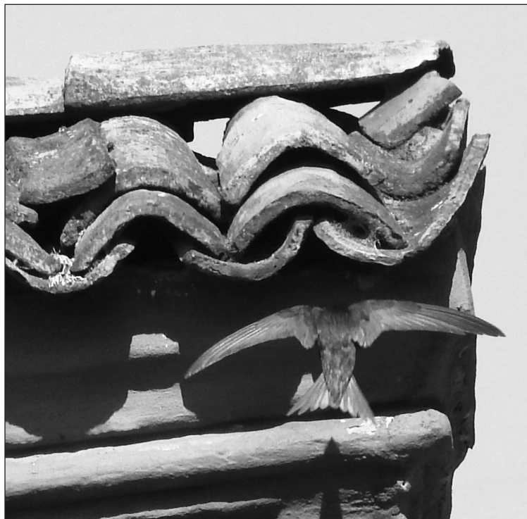
Fig. 32 – Apus apus su comignolo del Palazzo vescovile di Modena. Le cavità sotto i coppi sono il più importante sito di nidificazione del rondone comune e del rondone pallido (foto M. Ferri).
