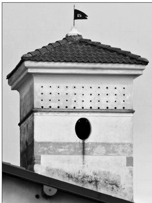
Fig. 23 – Torretta passerèra a Brescia (foto M. Ferri).
