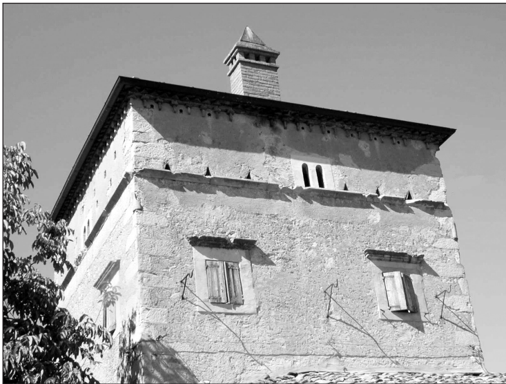
Fig. 11 – Casa torre nell'Appennino reggiano (foto M. Ferri).
