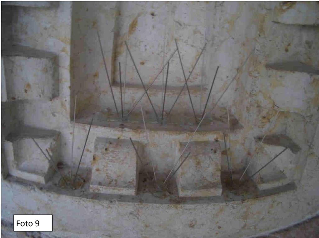
Foto 9 – Le punte sono alte così da non permettere un facile riempimento.
