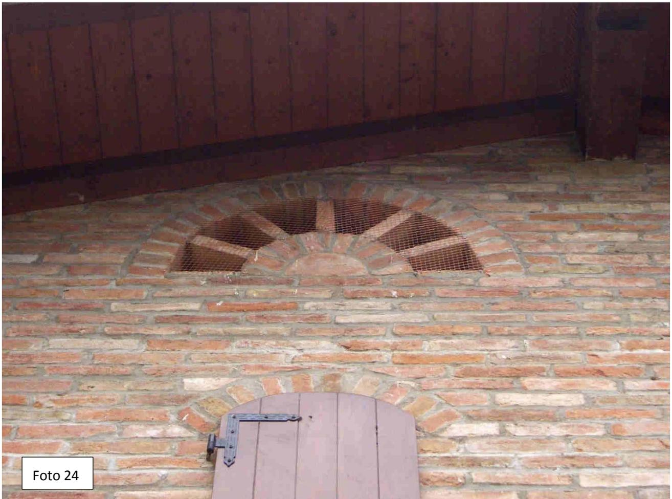
Foto 24 – Esempio di corretta chiusura a filo muro esterno di un'apertura facilmente utilizzabile dai colombi.
