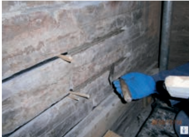
2. "Ristilatura armata" di giunti di malta alterni con materiale composito.
