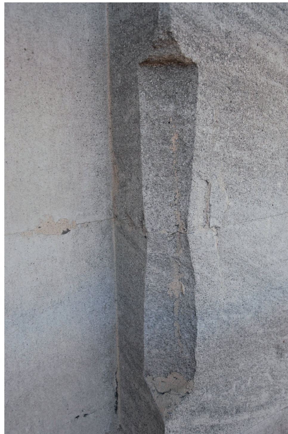
14. Piano III particolare di frattura a forma di clessidra
