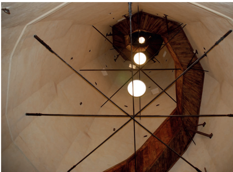
10. L'interno della guglia con la scala elicoidale in legno di 119 gradini
