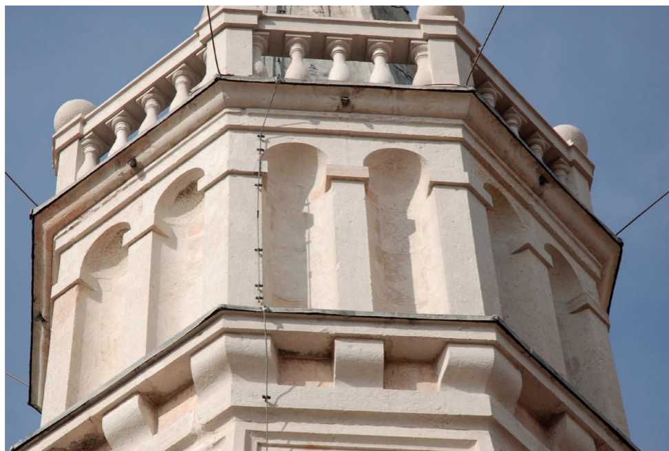
7. La balconata superiore dopo il restauro
