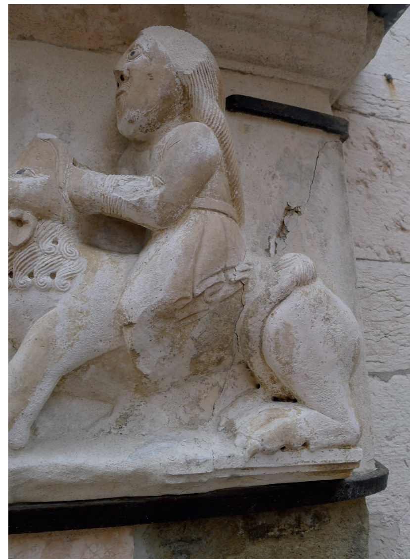
19. Danni causati dal sisma: si nota una lesione in diagonale sul modellato, con distacco di frammenti nella parte piana
