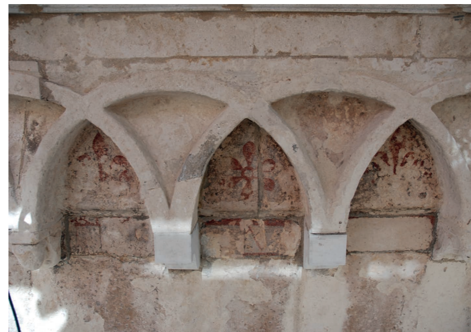
16. Piano I, particolare decori in colore rosso situati nella prima cornice marcapiano del lato est
