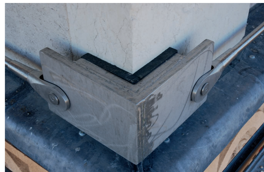
8. Particolare della cerchiatura in acciaio al VI piano
