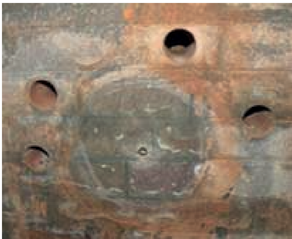
6. Fori di carotaggio nella muratura all'interno della torre.
