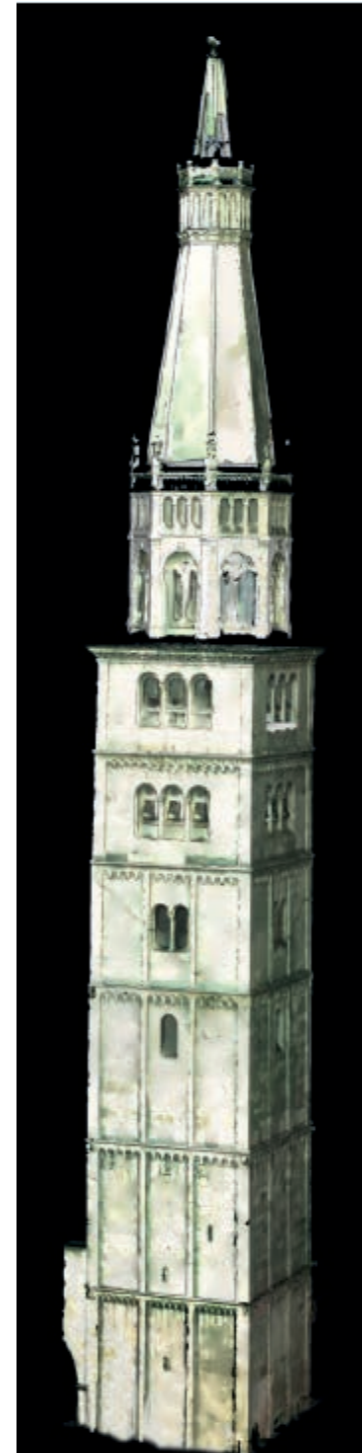
4. Modello tridimensionale della Torre Ghirlandina utilizzato per l'analisi e lo studio delle principali caratteristiche geometriche della struttura. Sul modello geometrico della struttura sono state riproiettate immagini fotografiche bidimensionali per conferirne un aspetto fotorealistico.
