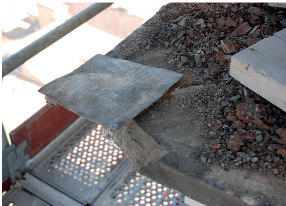
4. Particolare della copertura con la posizione nella quale è stata trovata la lastra incisa
