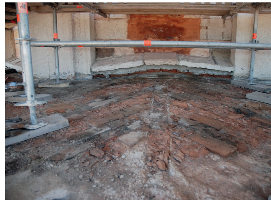
11. Sotto alle lastre in piombo la pendenza è realizzata con mattoni in cotto
