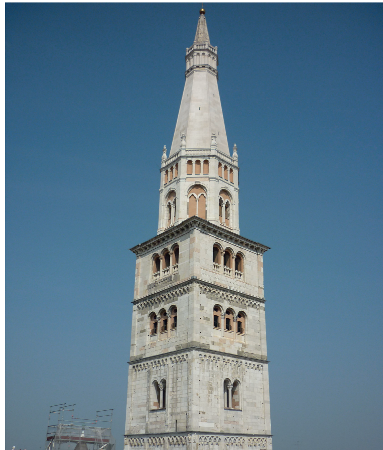
6. La torre dopo il restauro
