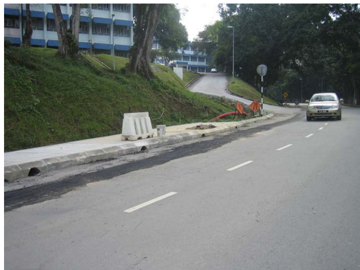
Jalan yang telah siap diturap di hadapan Fakulti Sukan & Rekreasi
