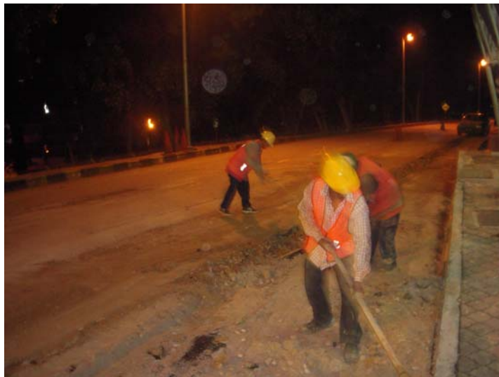
Kerja – kerja merata jalan yang telah digali
