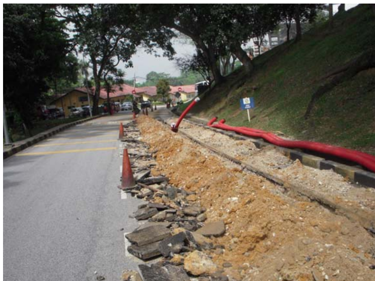
Kerja – kerja menggali dan menanam 150mm HDPE Pipe
