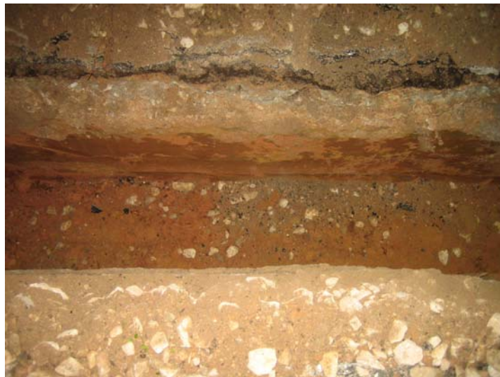
Pandangan atas parit untuk laluan 140mm HDPE paip yang telah siap digali
