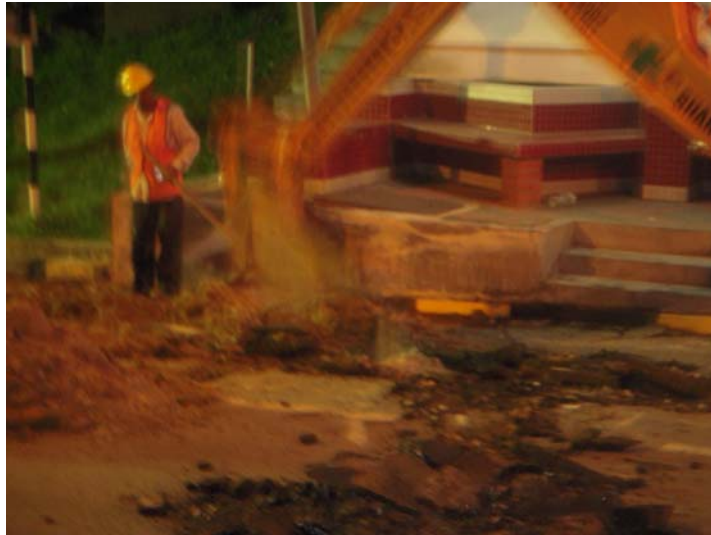
Kerja – kerja menggali parit berhadapan perhentian bas Kolej Perindu
