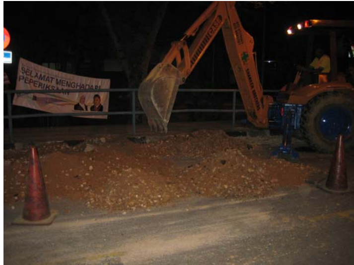
Kerja – kerja menggali parit untuk laluan 140mm HDPE paip di dalam kawasan Kolej Kenanga dan Kolej Cempaka
