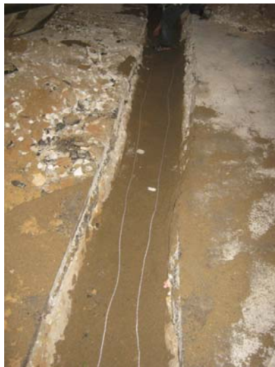
Proses penanaman HDPE Pipe Pada PE FPP Baru
