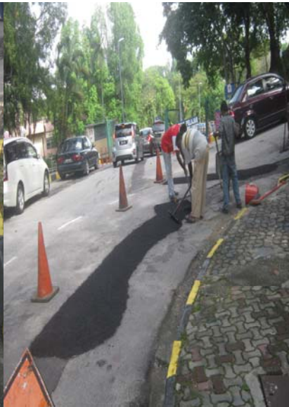
Proses pembaikan jalan Berhadapan fakulti undang- undang
