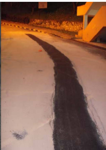
Proses penurapan jalan daripada PE FPP Baru dan Lama ke PE FSPU Lama dan Main Intake
