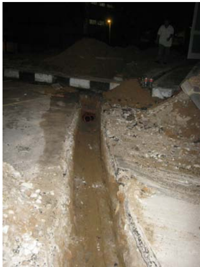
Proses penanaman HDPE Pipe Ke PE FPP Baru
