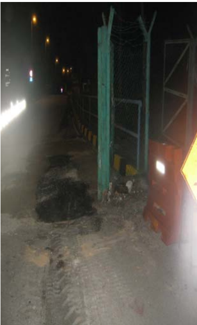
Penurapan jalan selepas proses Penyambungan kabel
