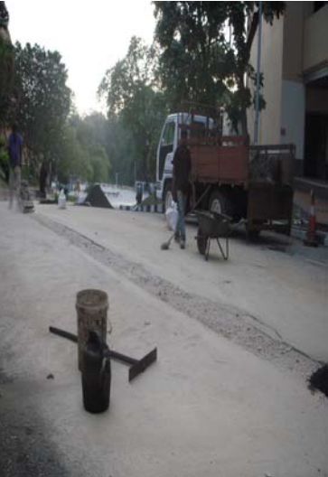
Proses penurapan jalan pada laluan kabel daripada PE FPP Baru ke PE FPP Lama
