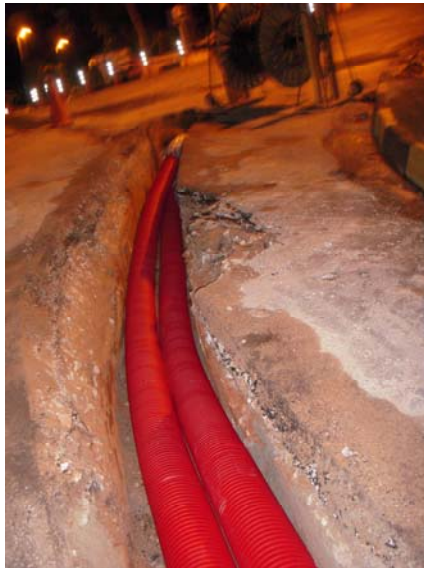
Proses penanaman HDPE Pipe Daripada PE FPP Baru dan Lama ke PE FSPU Lama dan Main Intake
