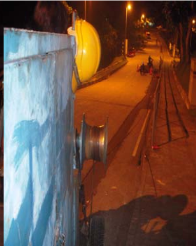
Merentang kabel menggunakan "cable winch" (berhadapan Kolej Cempaka/ Kenanga)
