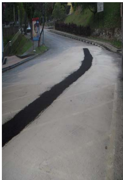
Proses penurapan jalan daripada PE FPP Baru dan Lama ke PE FSPU Lama dan Main Intake
