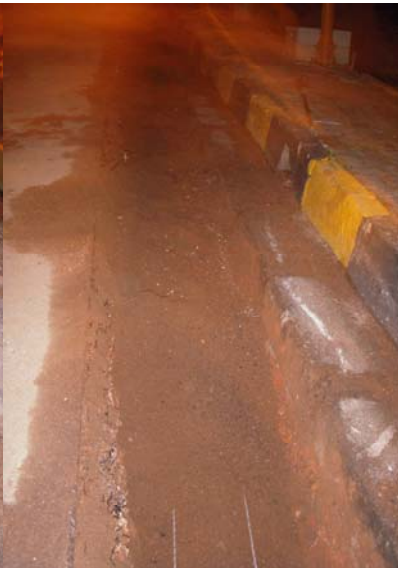
Proses penanaman HDPE Pipe Daripada PE FPP Baru dan Lama ke PE FSPU Lama dan Main Intake
