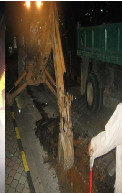
Proses penanaman HDPE Pipe pada laluan ke PPU
