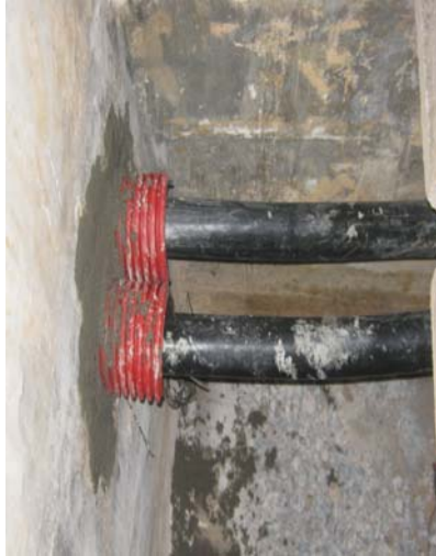
Daripada G.I Pipe ke dalam PE FPP Lama
