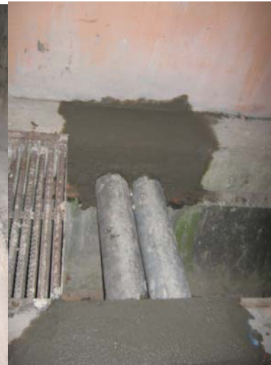
Penggunaan G.I Pipe untuk ke dalam PE FPP Lama merentas longkang
