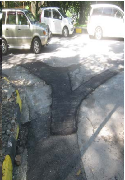
Proses pembaikan jalan Berhadapan fakulti undang undang
