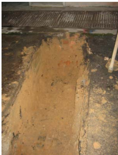
Keadaan "trenching" pada PE FPP Lama
