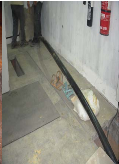
Rentangan kabel ke dalam PE FSPU Lama
