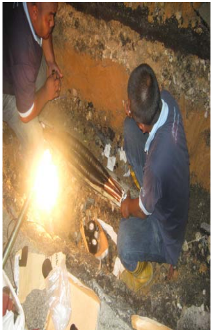
Proses penyambungan kabel
