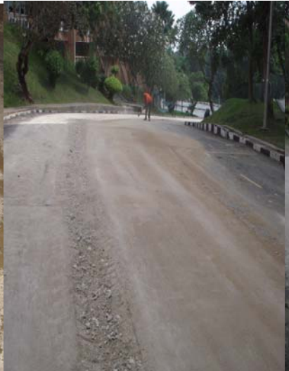
Proses pembersihan pada laluan kabel daripada PE FPP Baru ke PE FPP Lama
