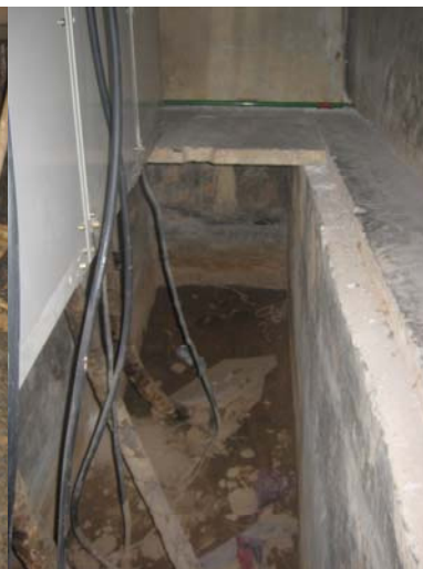
Keadaan "trenching" pada PE FPP Lama
