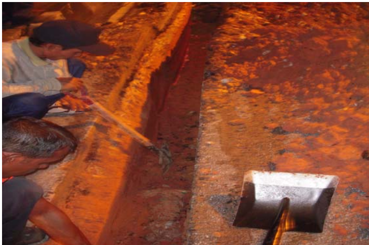
Trench yang telah siap untuk laluan 150mm HDPE pipe
