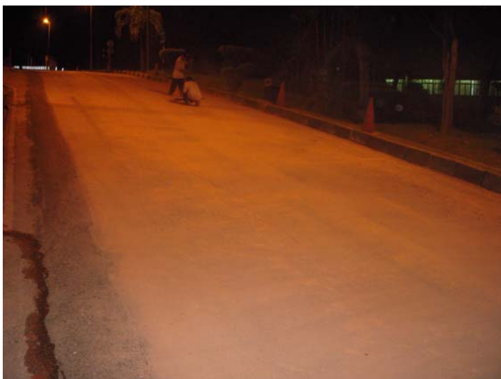
Kerja – kerja yang telah siap dan kerja membersihkan jalan sedang dilakukan
