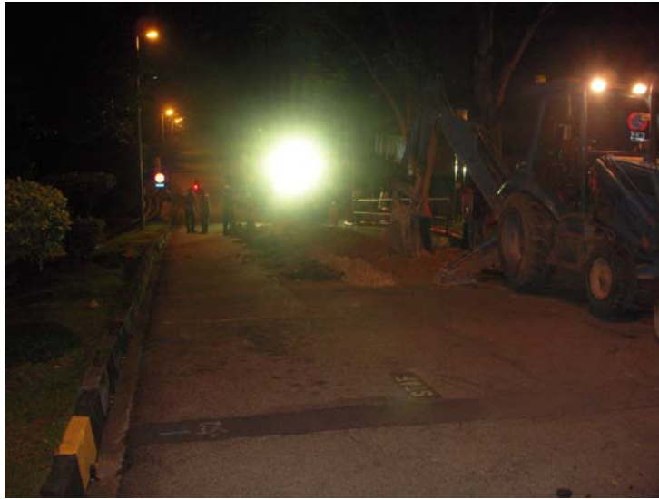
Kerja – kerja mengorek jalan sedang dilakukan
