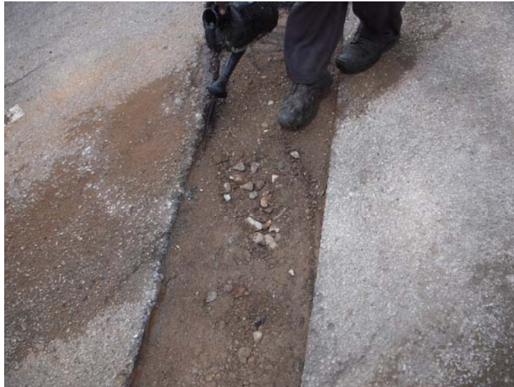
Kerja – kerja meratakan kawasan parit dan sedia untuk diturap
