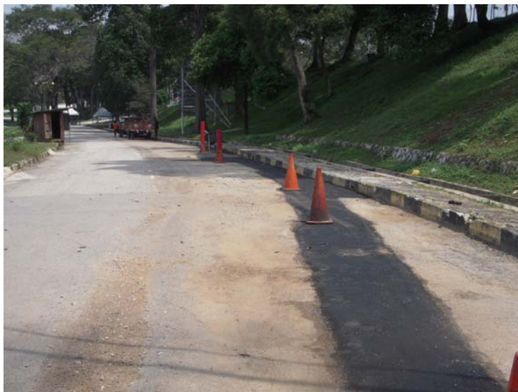
Kerja – kerja menurap jalan dari Pusat Konvesyen ke PE Tangki Penapis
