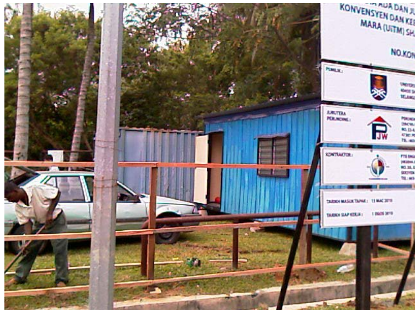
Kabin pejabat tapak, kontena stor dan kerja-kerja hoarding berhampiran Pintu 4
