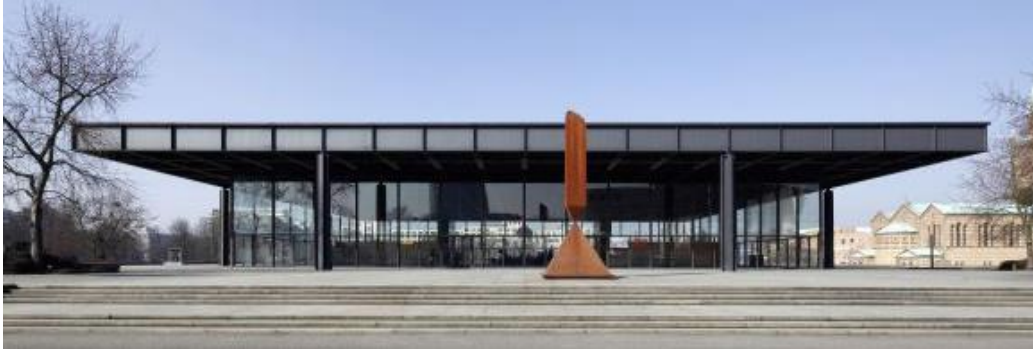
Figura 26. L'immagine rappresenta il prospetto principale della Neue Nationalgalerie. E' possibile notare la copertura a sbalzo e la presenza di esili pilastri cruciformi lungo il suo perimetro.
