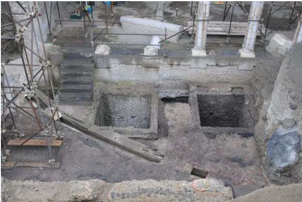
Fig. 63 – Cisterne utilizzate per la raccolta dell'acqua
