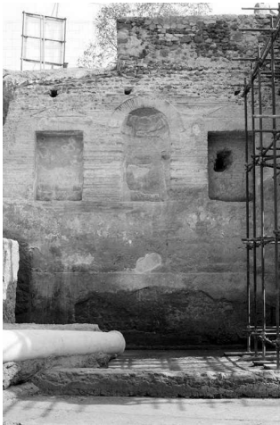
Fig. 17 - Muro con nicchie orientale
