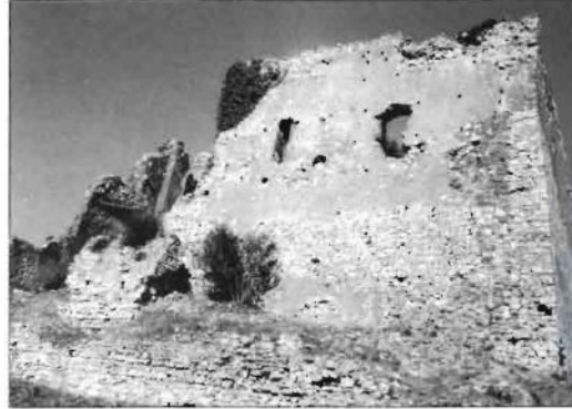
Donjon lato sud (Foto F. Cordella)
