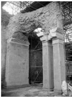
Fig. 11 - Prospetto ad arcate e pilastri: arcata orientale
