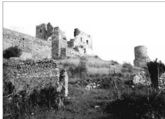
Donjon lato sud (Foto F. Cordella)
