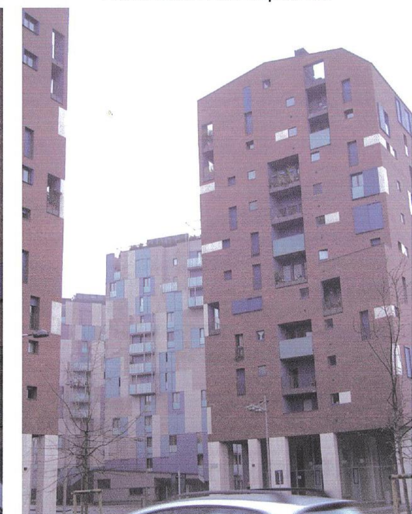
Foto 6. Edificio A2. Prospetto Nord-Est
