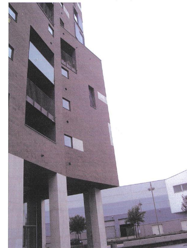
Foto 3. Edificio B2. Particolare prospetto Nord-Est
