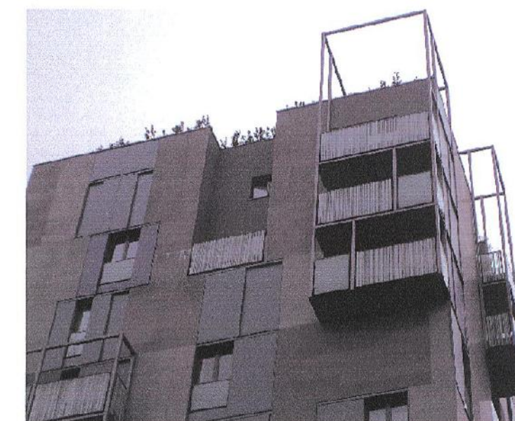
Foto 1. Edificio A2. Particolare prospetto Nord-Est
