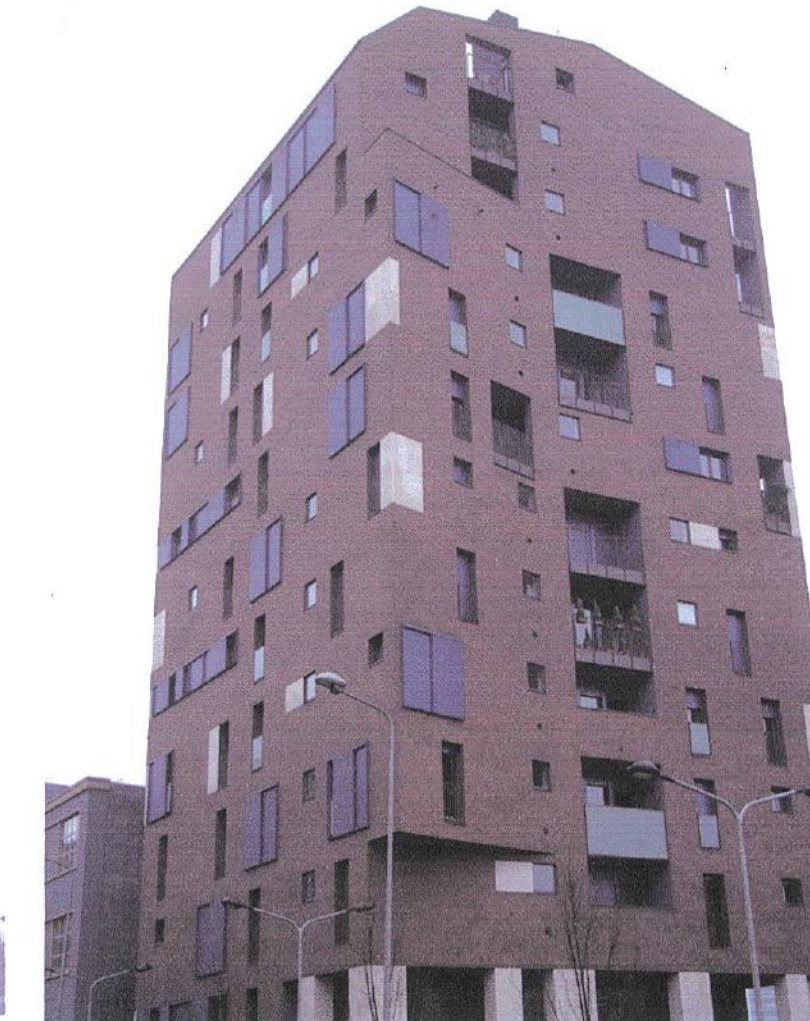
Foto 6. Edificio B1. Prospetti Nord-Est e Nord-Ovest
