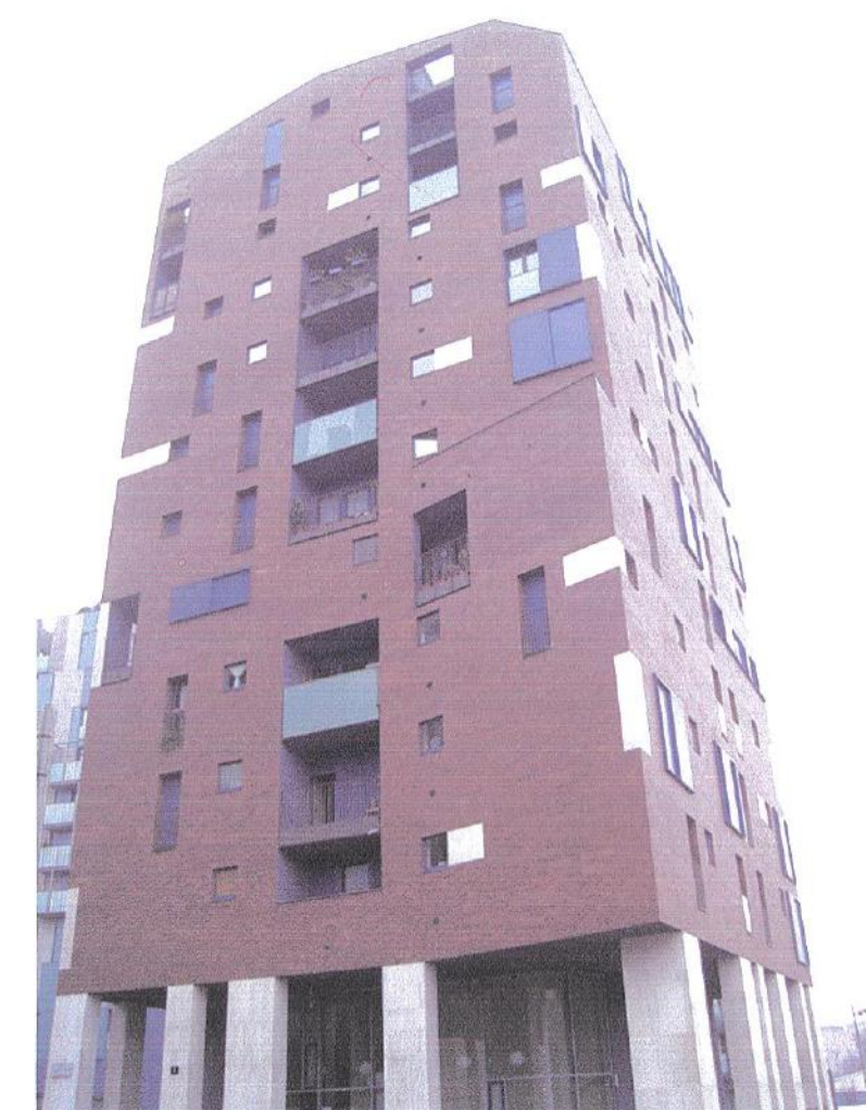
Foto 5. Edificio B2. Prospetto Nord-Est
