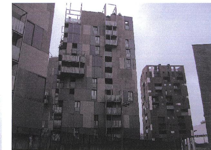
Foto 2. Edificio A2. Prospetto Sud-Est
