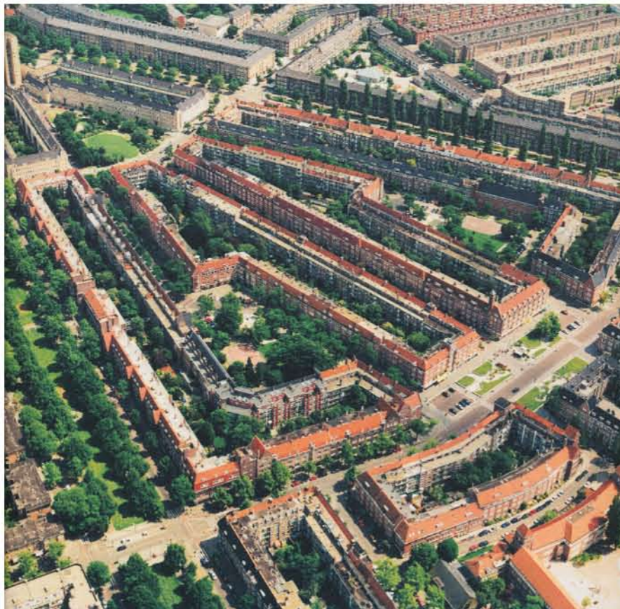
Photo aeriene du quartier de logements avec batiments types de l'extension de 1917
