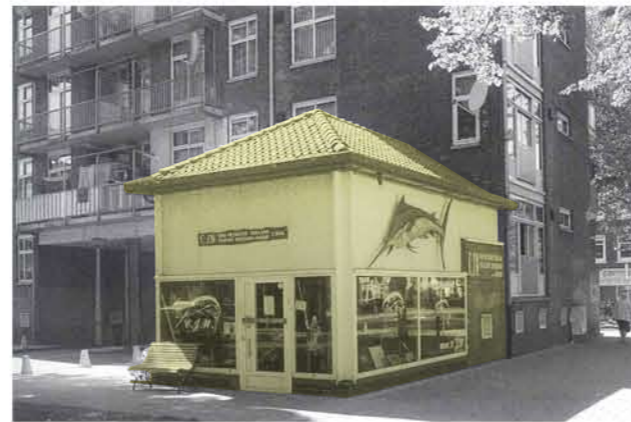
Un des deux magasins situé à l'extrémité du bâtiment
