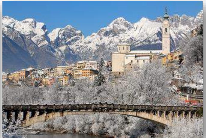
Immagine 2: Vista del ponte San Pietro in Campo
