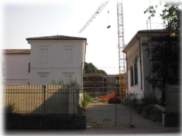
Foto 14a. Cantiere in via Montecchi Ristrutturazione ex ospedale
