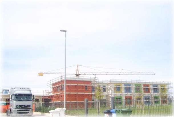
Foto 4b. Cantiere in via Iotti
