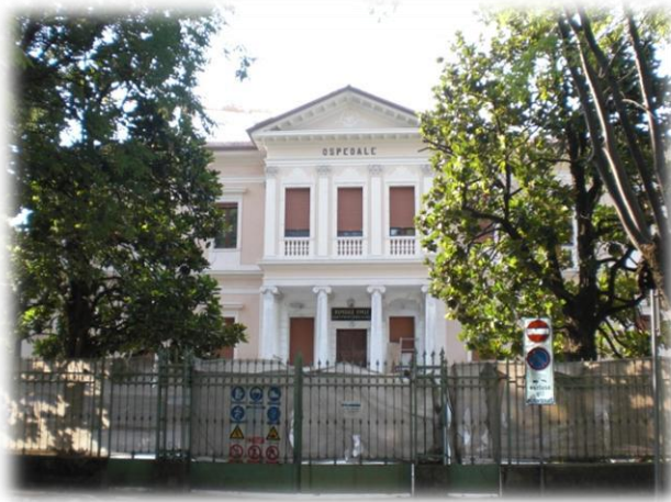
Foto 14b. Cantiere in viale Cadorna Ristrutturazione ex ospedale
