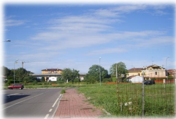
Foto 15. Cantiere in Sanzio
