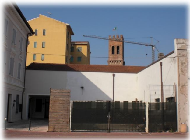
Foto 13. Cantiere in via Montecchi
