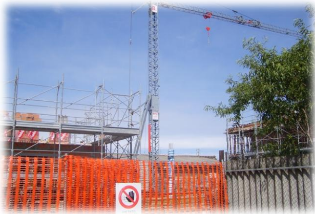
Foto 6. Cantiere in via Pavese
