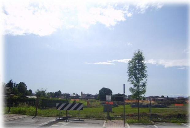
Foto 10b. Cantiere in via Mazzali
