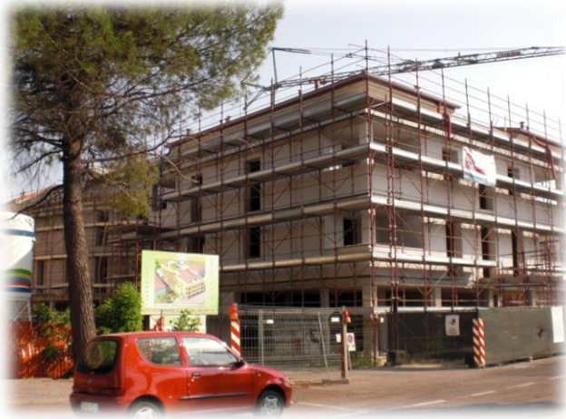
Foto 11. Cantiere in via Zonta
