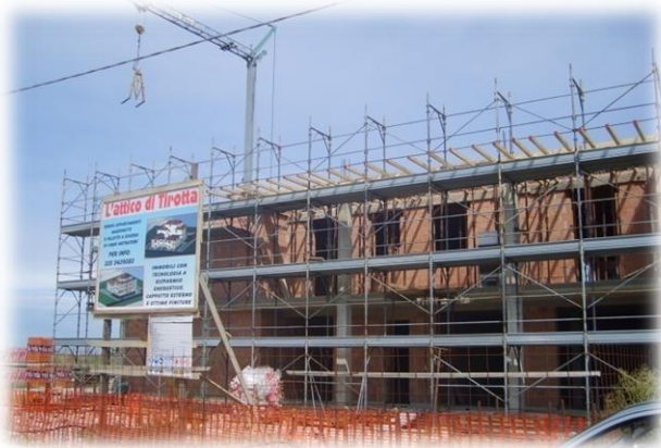
Foto 1. Cantiere in via Pasine
