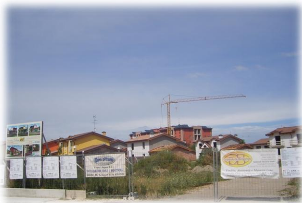
Foto 2. Cantiere in strada Donella
