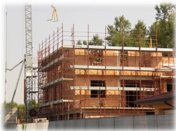
Foto 17. Cantiere in via General Cantore
