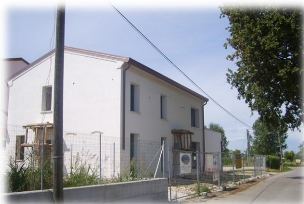
Foto 3. Cantiere stradello Opi
