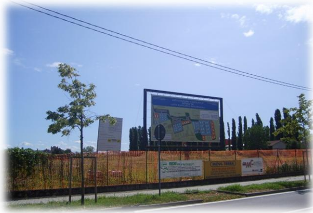
Foto 9. Cantiere in via Virgilio
