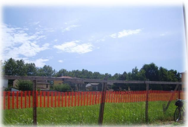
Foto 5. Cantiere in via Nuvolari
