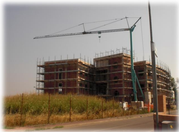
Foto 16. Cantiere in via Archimede
