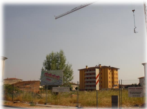
Foto 12. Cantiere in via Solferino
