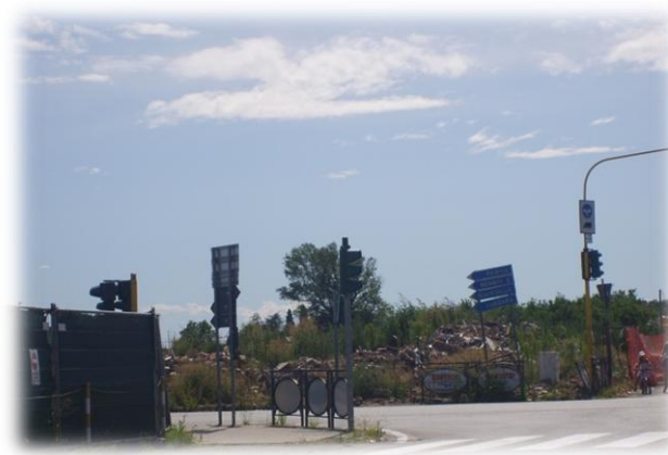
Foto 8. Cantiere tra strada Marzole e strada nazionale della Cisa S.S.N.62
